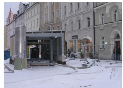
Im letzten Schritt wurden die oberirdischen Bauteile wie Übergabekabinen, Zugang zum Servicebereich und die Be- und Entlüftungsanlagen errichtet.
