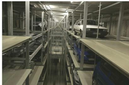
Jeweils zwei Regalbediengeräte pro Anlage ordnen jetzt die Fahrzeuge in die verfügbaren Plätze ein. Auf gleiche Weise werden die Fahrzeuge auch wieder mit der Chipkarte angefordert und an die Oberfläche geholt.
