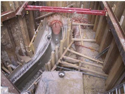
Zunächst mussten die unter der Straße liegenden Versorgungsleitungen verlegt werden. Das Bild zeigt die Kanalbauarbeiten.
