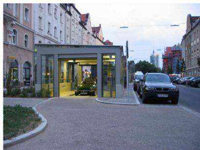
Ein Ausparkvorgang dauert durchschnittlich zwei Minuten. Die eingesetzten Schnelllaufotore tragen durch ihre sehr kurze Schließ- und Öffnungszeit von 2,5 Sekunden zum Nutzerkomfort bei.
