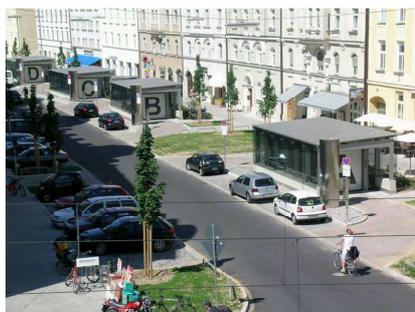
Über vier Kabinen ("A" bis "D") an der Straßenoberfläche können die Fahrzeuge mittels einer Chipkarte (Zugangsberechtigung) ein- und ausgeparkt werden. Die Übergabekabinen der nördlichen Anlage sind rollstuhlgerecht ausgebildet.
