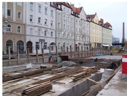
Nach dem Bau der Tiefgaragendecke folgte darunter dann der abschnittsweise Erdaushub und das Betonieren der wasserdichten Sohle.
